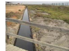
Foto 2. Obras de dragado del antiguo canal.
